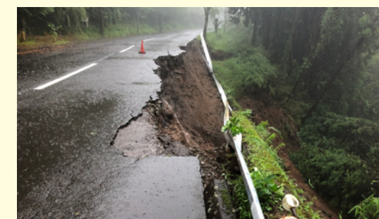
町道425号線法面(谷側)崩落 (2021年7月豪雨時)
